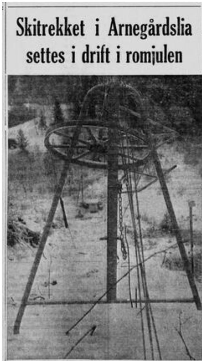
20. desember 1968 er det et bilde i Ringerikes Blad av skitrekket som settes i drift i romjulen. Trekket er 115 meter langt og drives av en elektromotor på 5,5 HK. Beregnet kapasitet er cirka 600 personer i timen.
