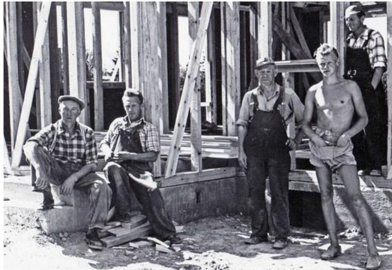
Etter at trevarefabrikken ble nedlagt, tok Arthur Gulbrandsen på seg å bygge lærerboliger ved Tyrifjord høyere skole (Adventistsamfunnet) på Vestre Rud på Røyse. Da engasjerte han flere snekkere fra Åsbygda og Haug. På bildet ser vi fra venstre Arthur Gulbrandsen, Karl Iversen, Karl Bølgenhaugen, en ukjent og Oddvar Tveter.
