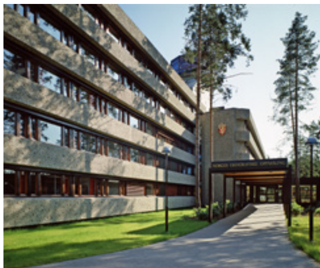
Det ferdige Kartverksbygget i 1980. Det er tegnet av det lokale arkitektfirmaet Sæther og Gythfeldt, som vant den utlyste arkitektkonkurransen.
