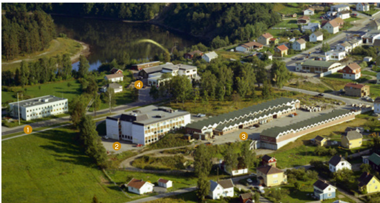
Nye bygg, reist rundt 1960. Til venstre den nye regimentsgården (1), og nabo på samme side av Osloveien er Nohregården (4). Midt på bildet ligger Ringerike Yrkesskole (2), og i forkant av skolen dominerer de to lager- og verkstedbygningene til Norderhov kommune (3).
